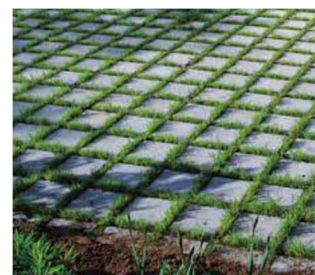
Exemple de pavé perméable à joints engazonnés
