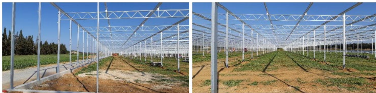
Figure 30 - Montage structure d'une serre photovoltaïque agricole. Reden.
