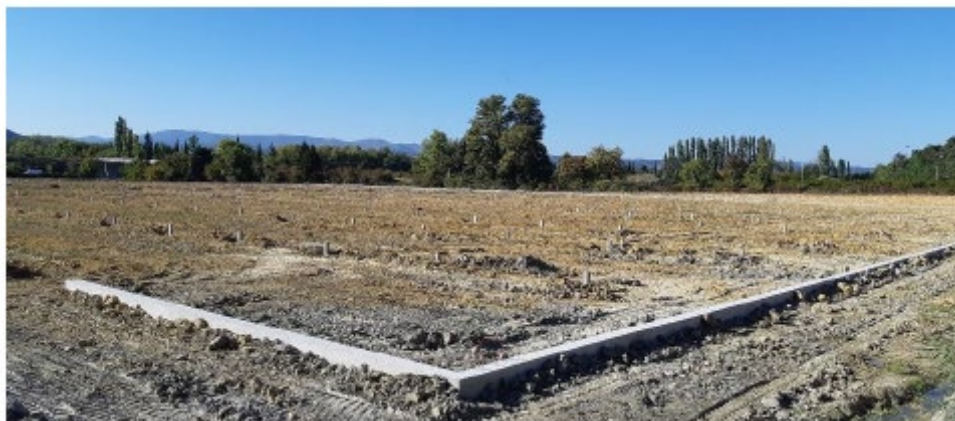
Figure 32 - Fondations béton extérieures (longrine). Reden.
