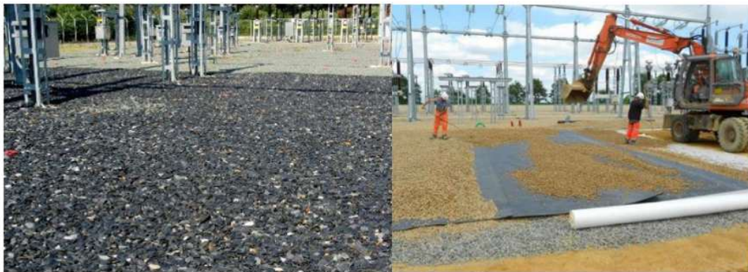
Figure 11 : Détail de la solution paillage minéral Zero phyto
