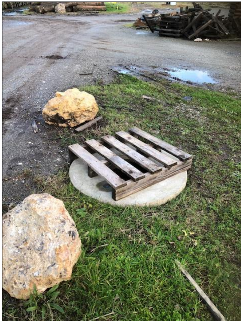
Photographie 3 : tête du forage actuelle non conforme
