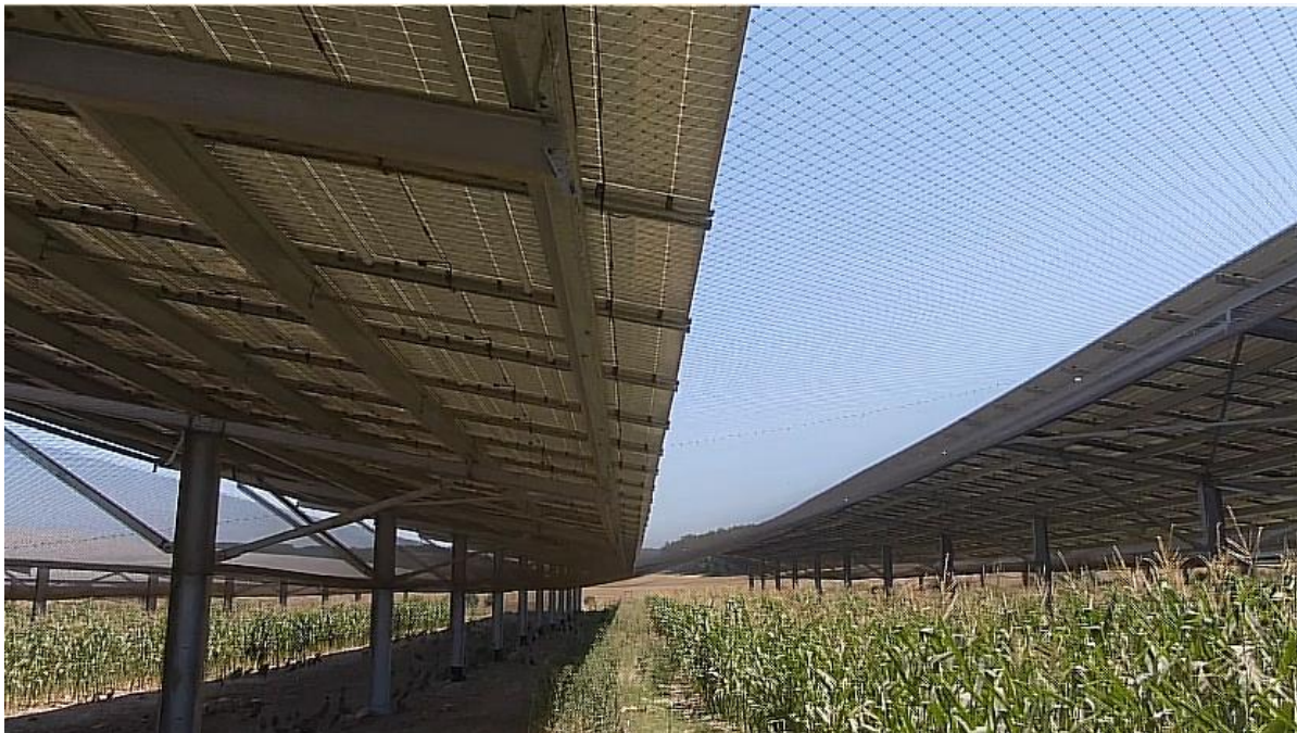
Figure 6 : Photographie d'une volière agricole photovoltaïque développée par Technique Solaire avec l'aménagement du parcours extérieur avec des rangs de maïs permettant la conservation du comportement de dissimulation des oiseaux lors de leur vieillissement.
